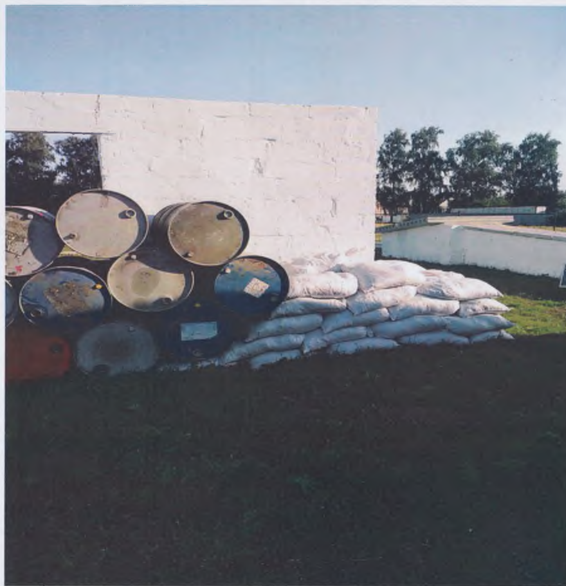
Комбинированная защита зданий и сооружений
